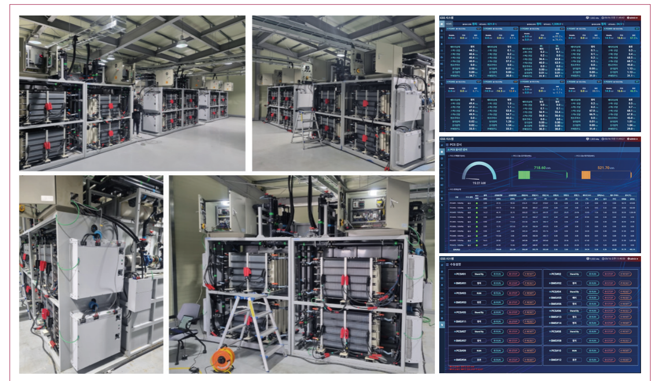
그림 7 MW급 VRFB 시스템의 실증사이트 내부 및 PMS
